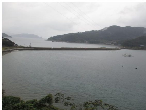
漁生浦島と有福島をつなぐ防波堤道路（左）
