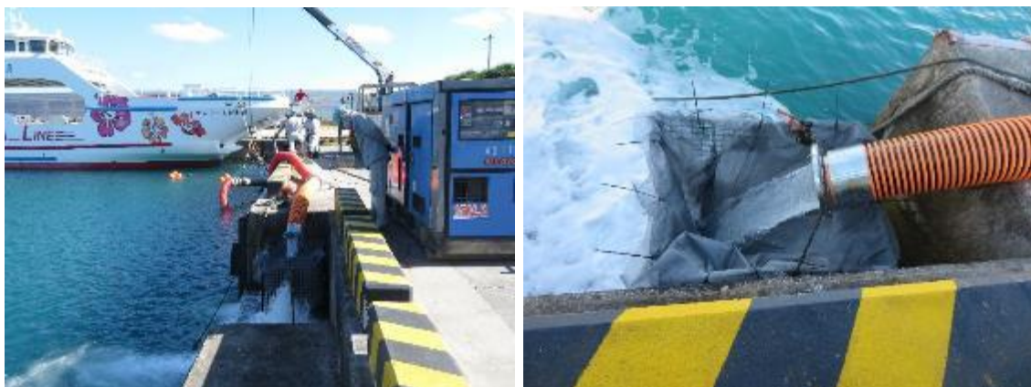
海底からポンプで海水を汲み上げる作業（左）、軽石を分離するためのネット（右）
