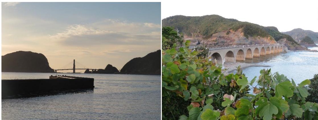
上甕島と中島を結ぶ甕大明神橋（左）、中島と中甕島を結ぶ鹿の子橋（右）
