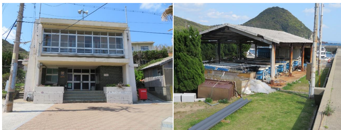
山口県漁協蓋井島支所の全景（左）、アワビの中間育成施設（右）
