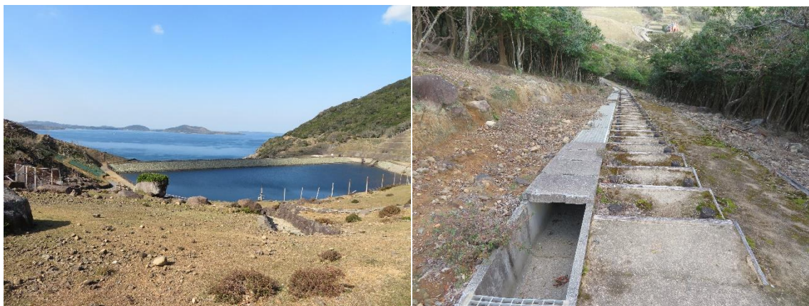
野首ダムの全景（左）、山道に沿ってつくられた集水の水路（右）
