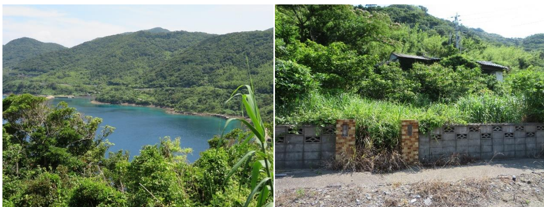
山の中腹に造られた県道（左）、草木に覆われた廃屋（右）
