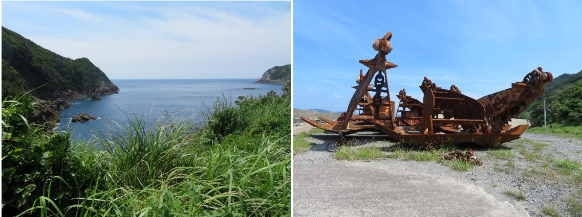
沖合に浮体式風力発電施設が設置されていた天見ノ浦湾（左）、旧小中学校脇に置かれていた固定用のアンカー（右）
