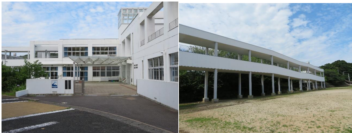
奈留小中学校の建物（左）、高校とつなぐ長い渡り廊下（右）
