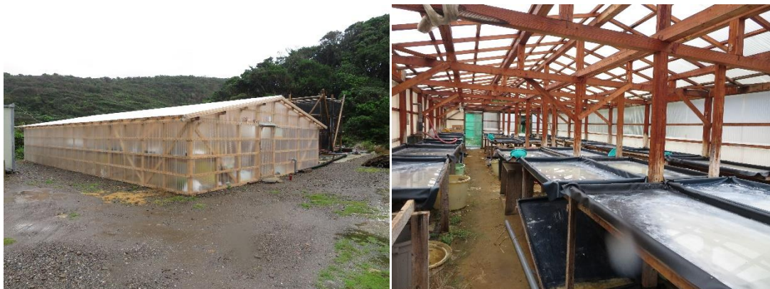
天日製塩場の建物（左）、海水を満たした浅い平板の容器（右）
