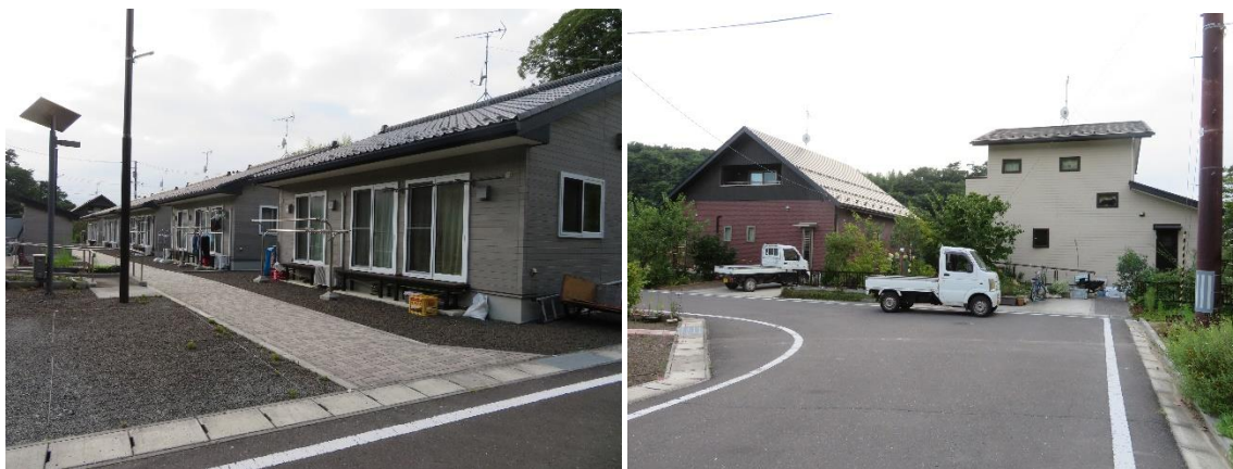
災害復興市営住宅（左）、同じく区画内に建つ自主再建住宅（右）
