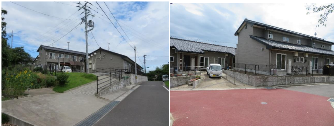
第1期工事で建てられた災害公営住宅(左)、第2期工事で建てられた災害公営住宅(右)
