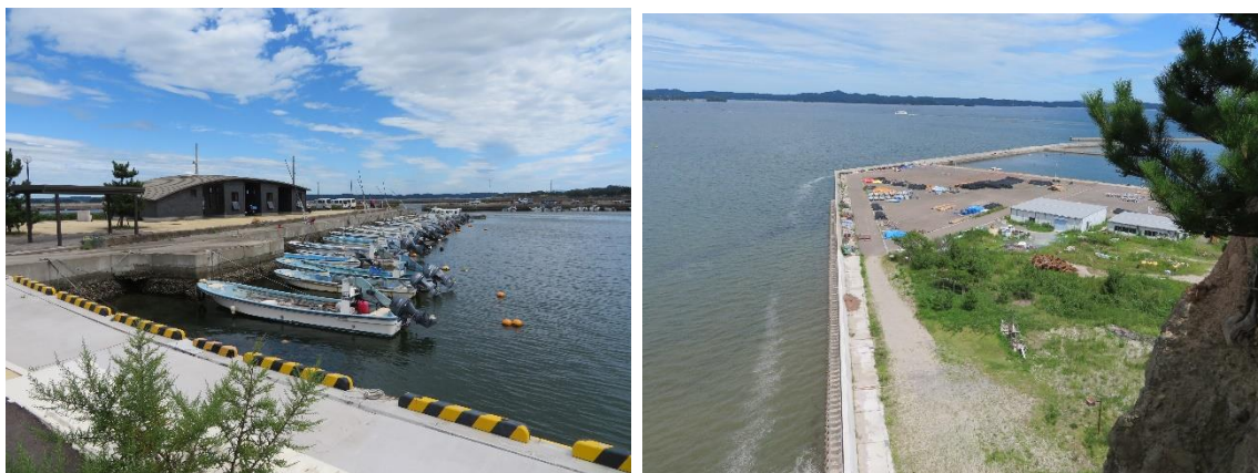
船客待合所と港内に係留されている船外機（左）、ノリ養殖の資材置き場と作業場を兼ねた広い埋立地（右）
