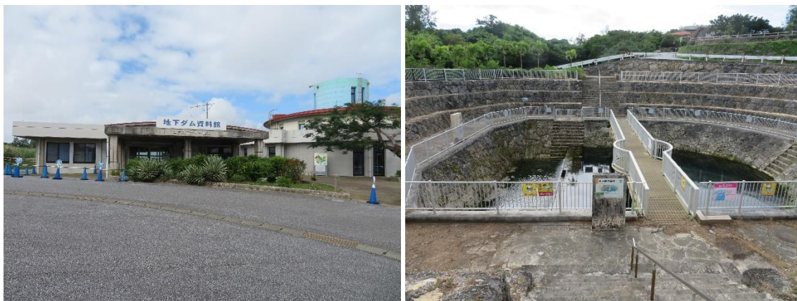
地下ダム資料館（左）、皆福地下ダムの水位水質監視施設（右）
