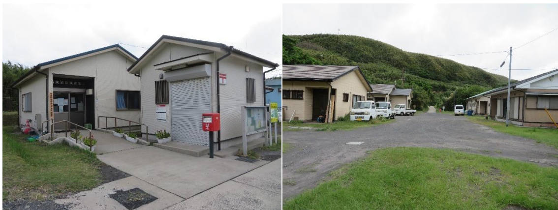
新しく整備された出張所と郵便局（左）、村営住宅（右）
