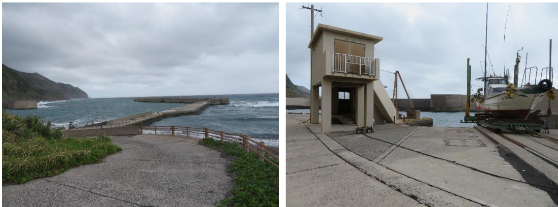
切石港のフェリー接岸岸壁（左）、漁港区域の斜路と建物（右）
