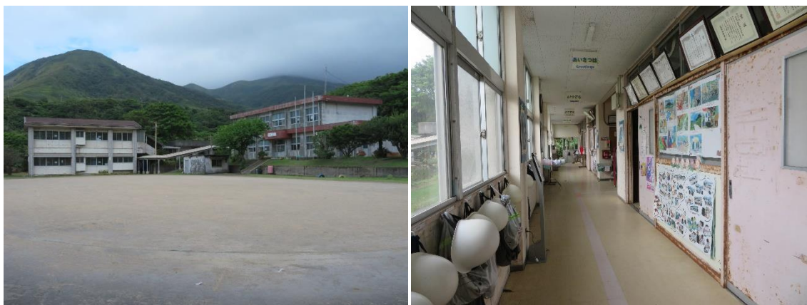
村立諏訪之瀬小中学校の校舎（左）、校舎の廊下（右）
