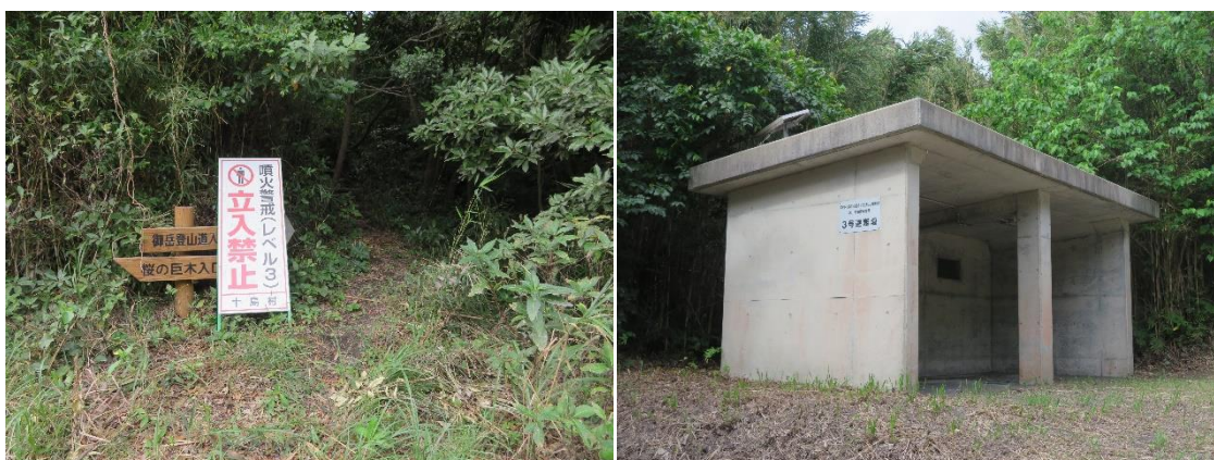
登山道入り口に立てられた立入禁止の看板(左)、道路脇に設けられた避難壕(右)
