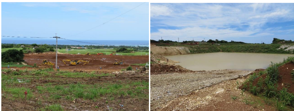
圃場整備の工事現場（左）、溜池の工事現場（右）
