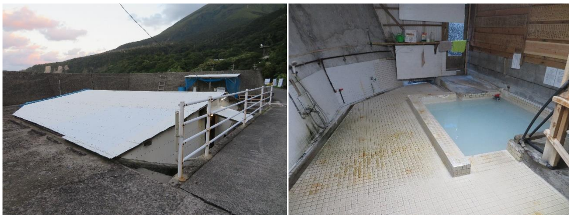
道路下の湧く西区温泉の建屋（左）、西区温泉の浴室（右）
