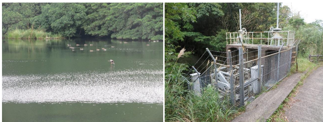
カモが泳ぐ御池(左)、下流に設けられた九州電力の水力発電所の取水口
