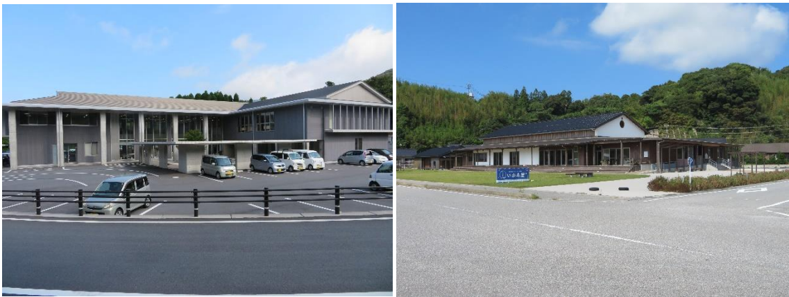
西ノ島役場の新庁舎（左）、旧役場跡に整備された町立図書館・いかあ屋
