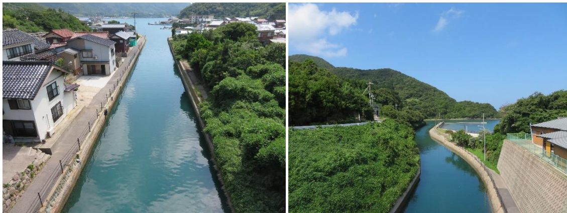
運河に架かる橋から南（美田湾）側を望む（左）、橋から北（外浜側）を望む（右）
