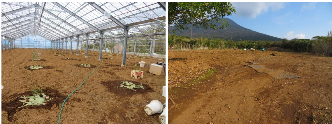
新設された温室に植えられたフルーツレモンの苗木（左）、温室を拡大するための造成工事（右）
