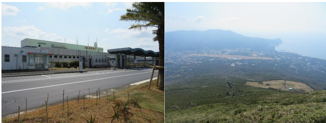
八丈島空港ターミナル（左）、2つの山の間につくられた飛行場（右）
