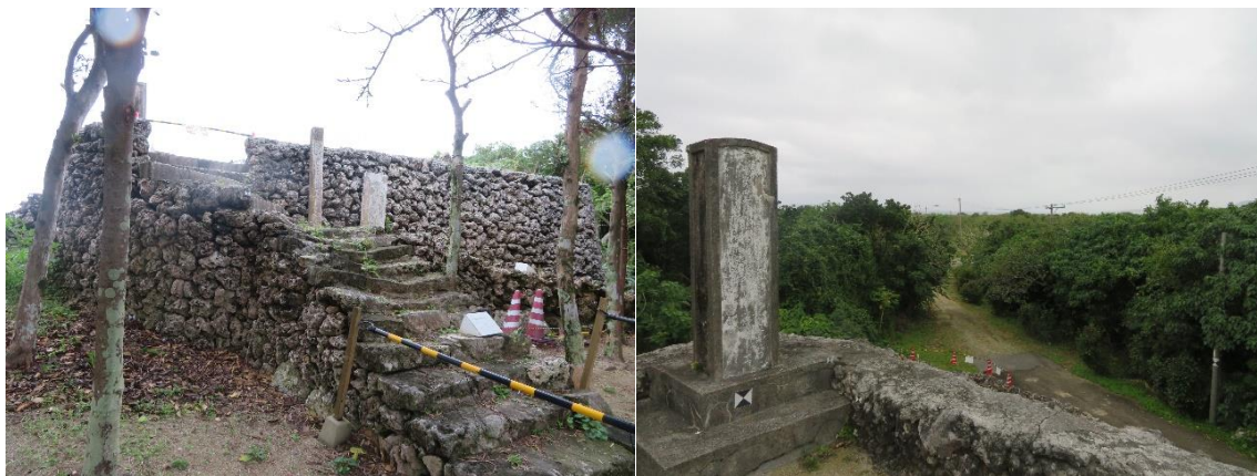
修理のための解体工事が進む小城盛（左）、小城盛からの眺め（右）
