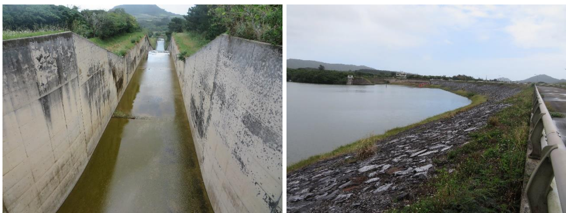
底原ダムの放水路（左）、真栄里ダムの堤体（右）
