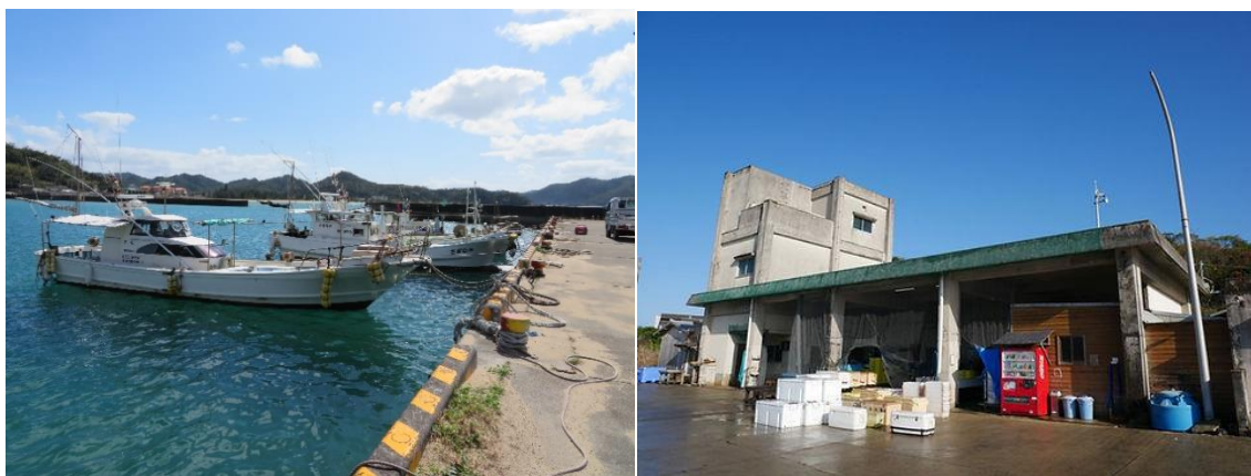
赤木名漁港に係留されていた釣り漁船（左）、奄美漁協の建物（右、漁協HPより引用）
