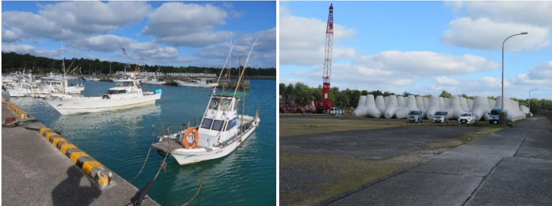
宇宿漁港に係留されている漁船（左）、漁港用地内のテトラポットの製作ヤード（右）
