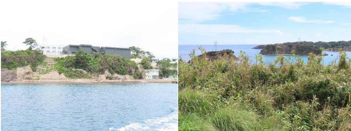
黒い建物が運用局舎（左）、本島からの電気・水道の中継地・海老島（右）
