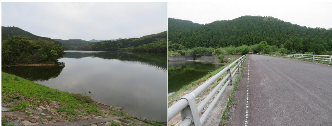
繁敷ダムのダム湖（左）、ダムの堤体（右）
