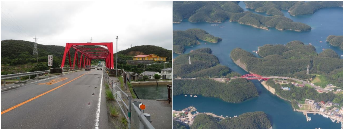
大船越瀬戸と大船越橋（左）、久須保水道と万関橋（右）
