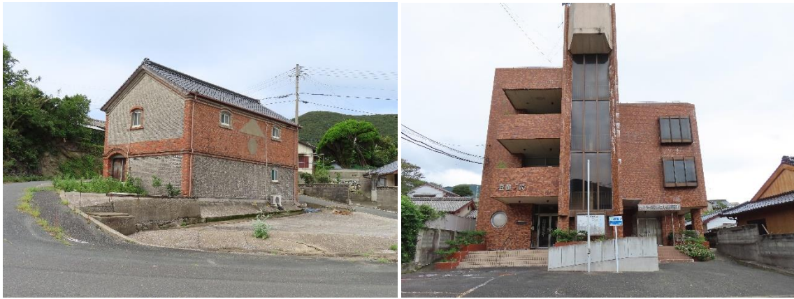
浅藻漁港に残る廻船問屋市丸のレンガ造りの旧倉庫（左）、豆酏住民センターの建物（右）
