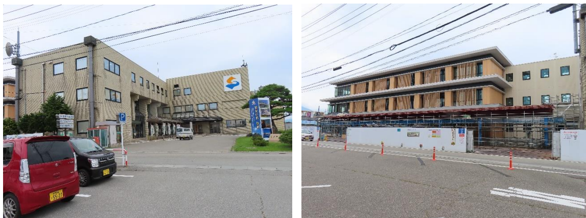
佐渡市役所の現庁舎（左）、隣接地に建設中の新庁舎（右）
